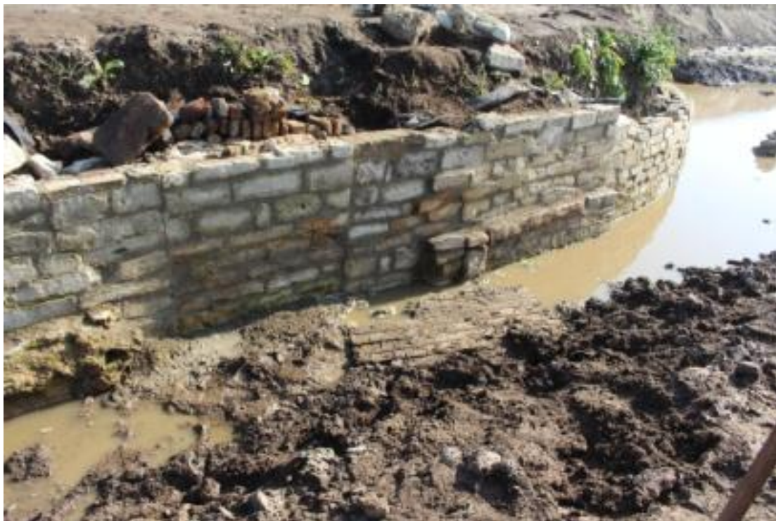
De gerestaureerde muur van de achterpoort.
