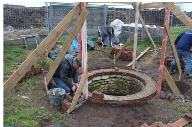
De put wordt opgemetseld en blijft in de toekomst zichtbaar
