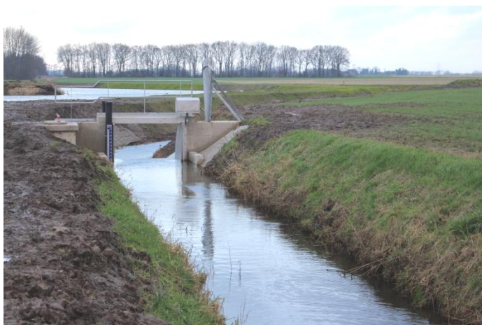
De stuw die het water in de beek moet reguleren en de buitengracht van water voorziet
