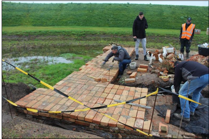
Metselen aan de bovenzijde van de vierkante toren om op die manier de onderliggende lagen te beschermen
